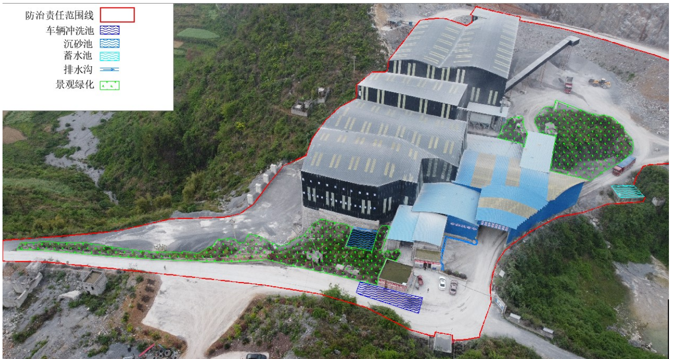
项目工业广场竣工后，现场水土流失防治现状照片
